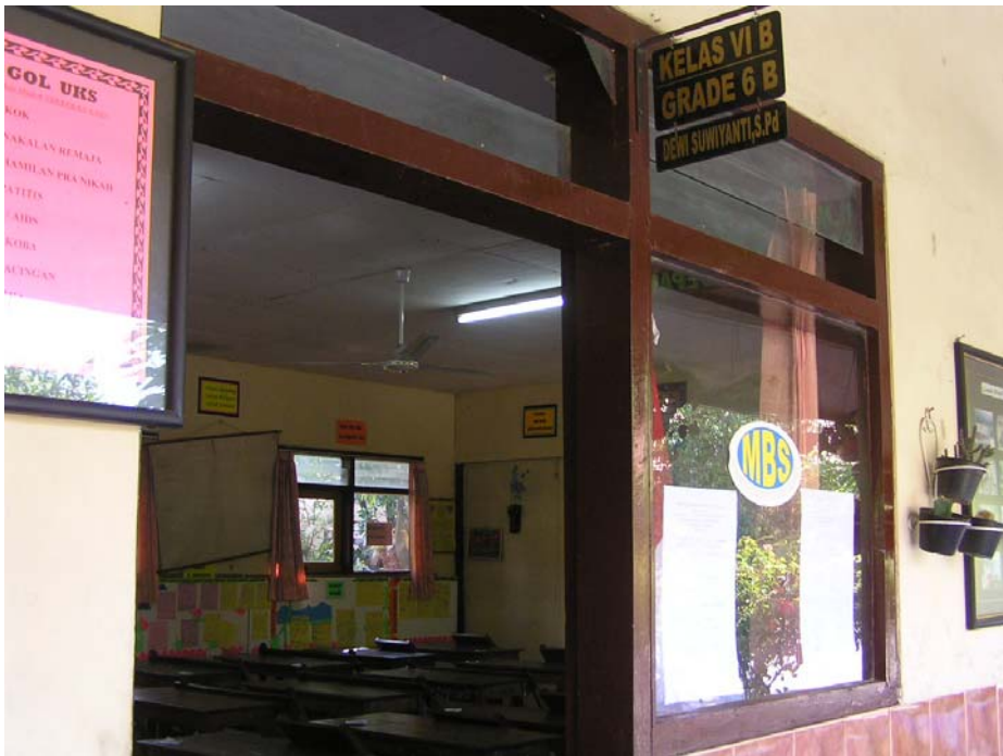
Gambar 5.14 Ruang Kelas V dan Kondisi Ruangan Kelas
