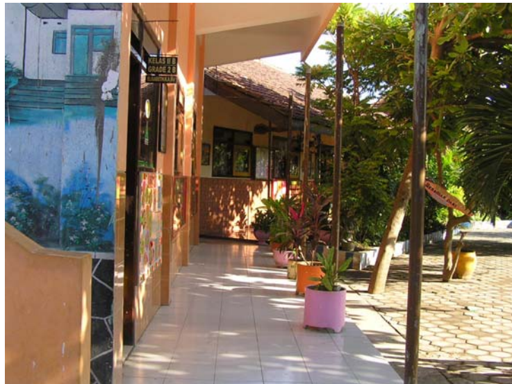
Gambar 5.17 Gedung Kelas Satu Lantai Bawah
